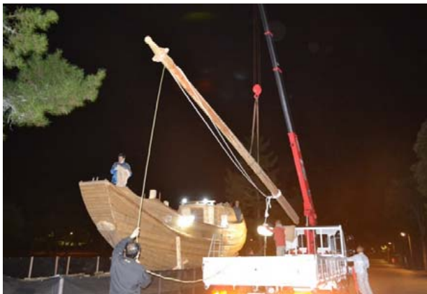
クレーンで帆柱を持ち上げ、いよいよ設置
