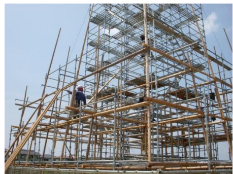
丸太足場組みの作業
